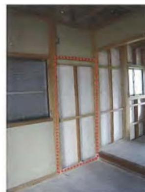
「A-435」の施工講習で用います。半間の壁に真壁で構造用合板を施工します。壁体内には土壁があるのが理想ですが、土壁でなくても問題ありません。土壁でない場合には、土壁を想定して柱面から25mmほど奥に入ったところ（チリの幅だけ奥まったところ）に面材を張っておいてください。このとき、裏残は柱頭・柱脚の30cm程度の範囲には入れないで下さい。
