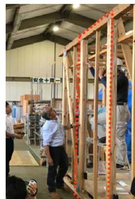
「A-233 カ」の施工講習で用います。半間の壁に大壁で構造用合板を施工します。天井位置に廻り縁、床位置に幅木を設けて下さい。間柱はなくても構いません。筋かいは入れないで下さい。
